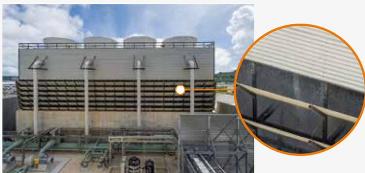
沖縄県うるま市にある中城バイオマス発電所では、発電で使用する冷却水を海水ではなく工業用水を使用しております。通常、海水を使用して海に流すのが一般的ですが、排水処理設備を介して下水処理場に送水することにより周辺海域の生態系を乱さず、沖縄の美しい海の保全に努めています。
