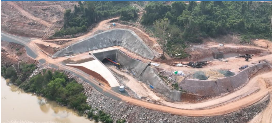
迂回トンネル出口掘削工事
