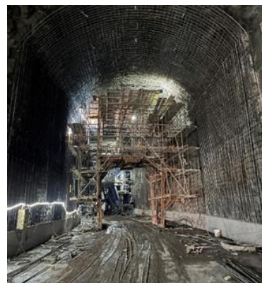
上流入り口補強工事
