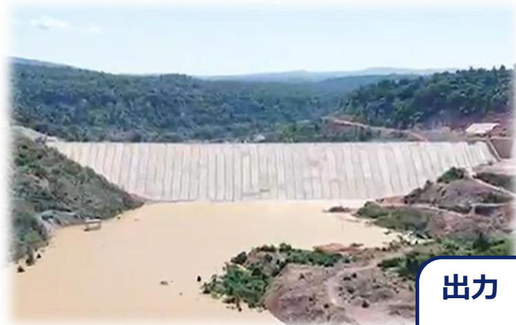
水力発電所工事進捗：ダム
