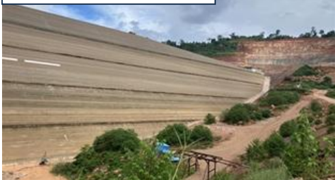
建設中のダムの様子
