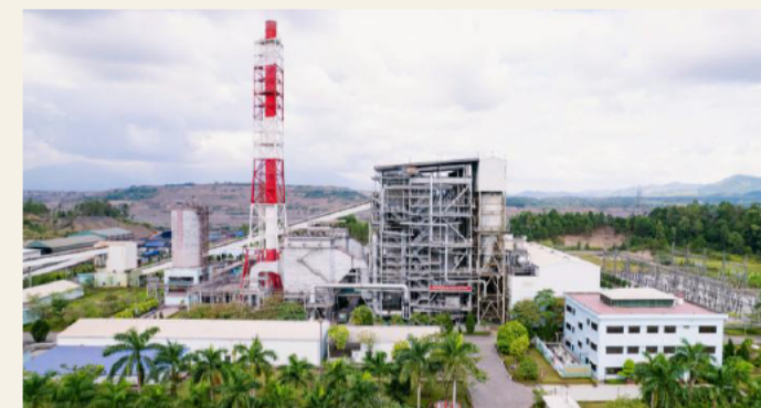
Na Duong石炭火力発電所
