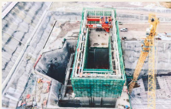
タービン発電設備
